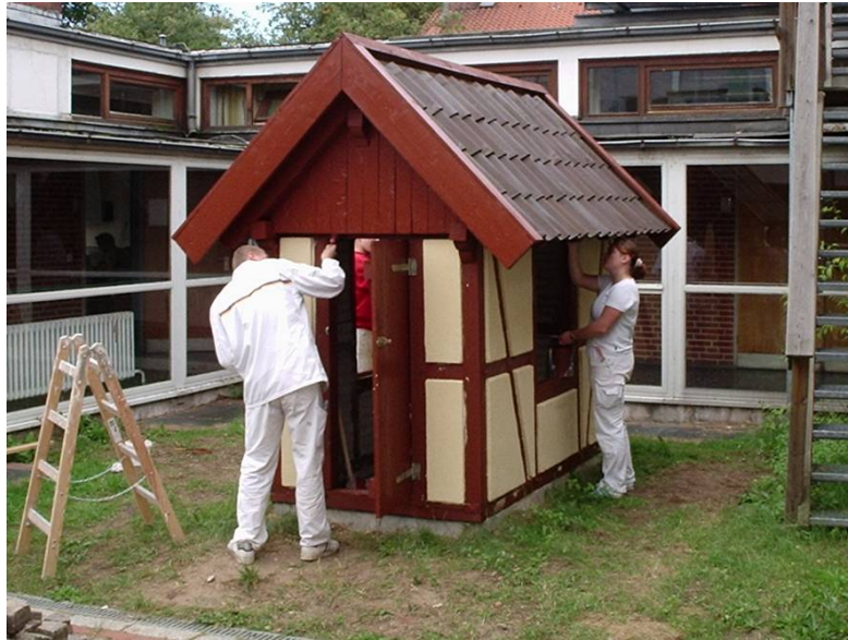
Abb. 4: Beschichtung des Holzwerkes
