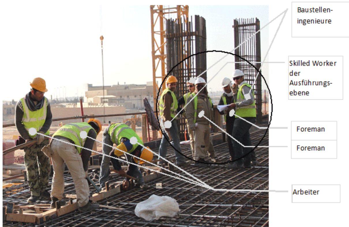
Abb. 3: Baustellenarbeit in Ägypten
