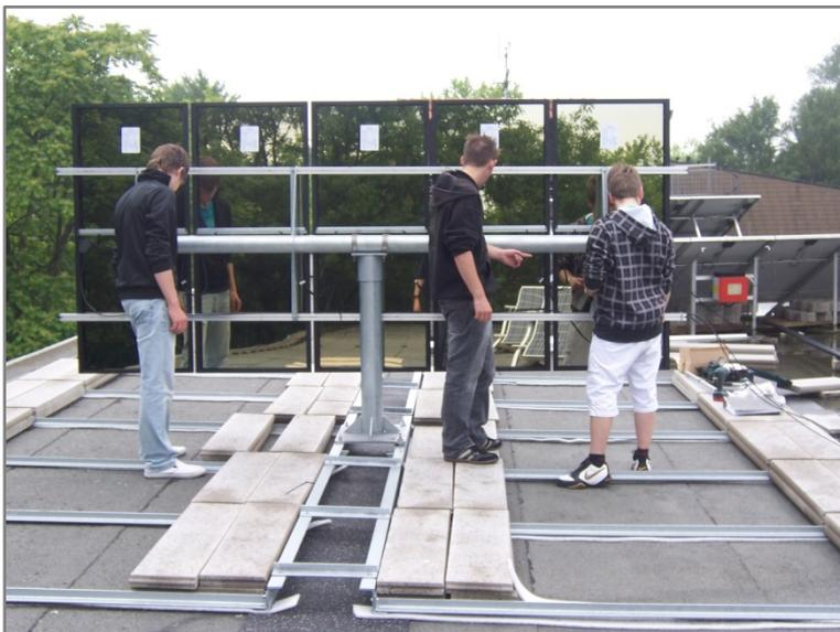
Abb. 6: Drehgestell mit Dünnschichtmodulen
